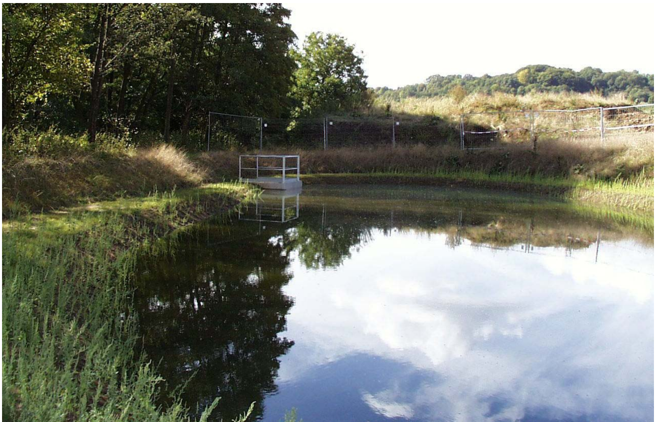
Schönungsteich der Teichkläranlage
