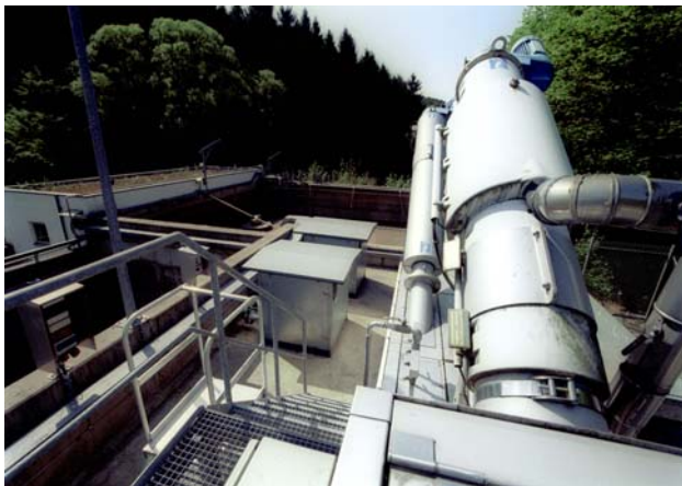
Von der Sieb- und Sandfanganlage fließt das Abwasser im freien Gefälle zur biologischen Reinigung in den SBR-Reaktor.
