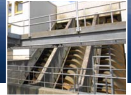
Schneckenpumpwerk
