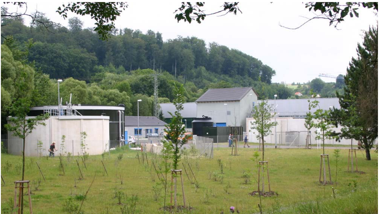
Teilansicht der Kläranlage Dirmingen
